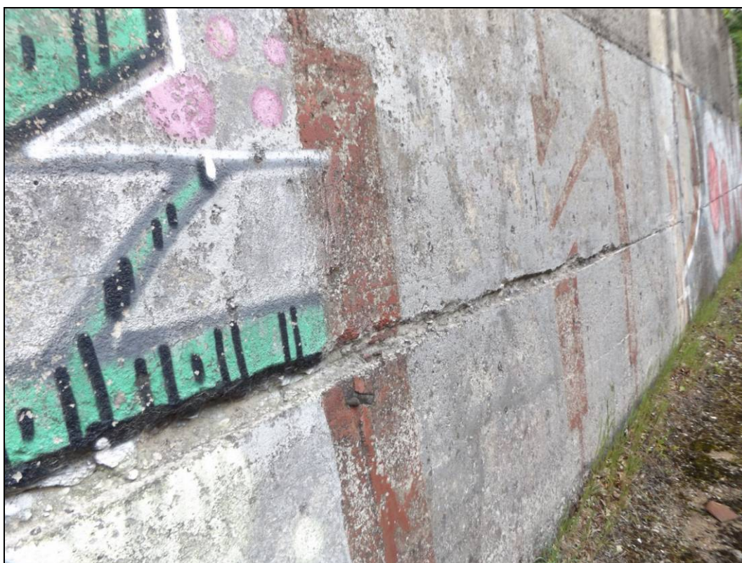
Obr. č. 5 - pohled na zárubní zeď zleva (hloubková degradace u přiznaných vodorovných pracovních spár)
