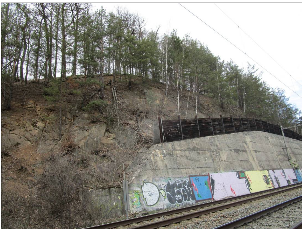
Obr. č. 7 – pohled na zárubní zeď na horní hraně záchytná bariéra z ocelových profilů a dřevěných fošen
