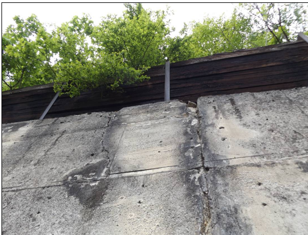
Obr. č. 6 – pohled na degradovanou korunu zdi s opady
