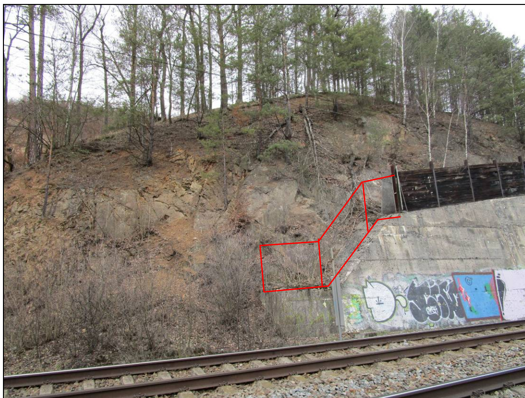
Obr. č. 8 – červeně je naznačen návrh rozšíření záchytného plotu v rámci sanace zárubní zdi
